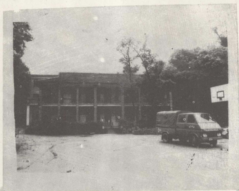
原四川省立西泉中学校教学楼
