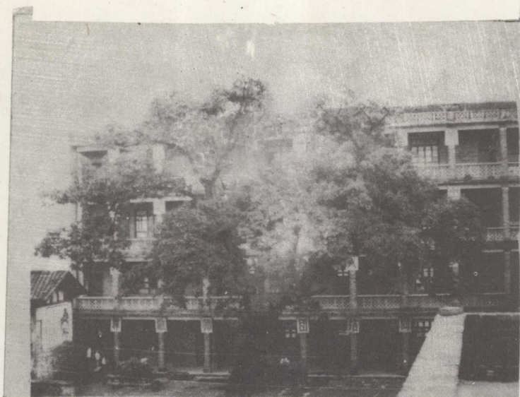
铜梁县蒲吕乡中心小学教学楼
