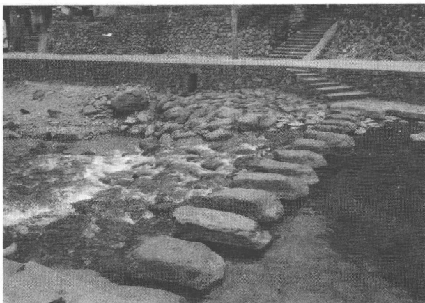
图 1-4 石杠,一种古老而简易的桥梁
