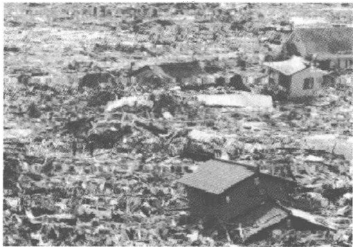
图 1.1.1 2011 年日本东部海域地震海啸摧毁岩手县陆前高田市
