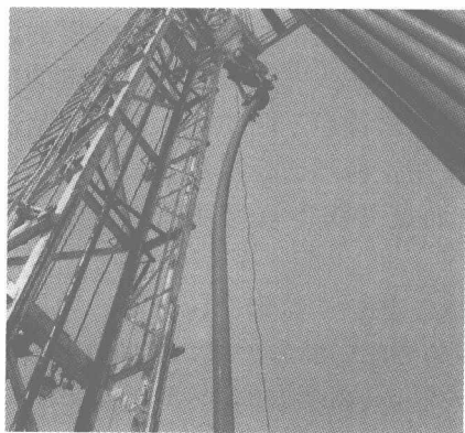
图 1.6 某盐穴储气库造腔内管弯曲
