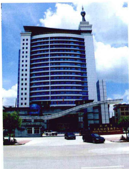
钦州市交通组织管理中心大楼。（滕广茂 摄）
