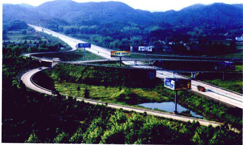
桂海高速公路钦州卜家立交。(冯 涛 摄)
