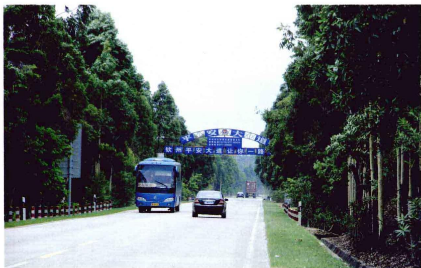
南宁至北海二级公路钦州那丽路段。（滕广茂 摄）
