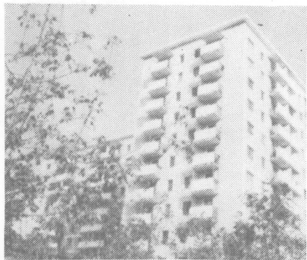
▼固体废物可生产建材。图为北京用高炉渣制水泥膨珠混凝建成的高层建筑。
