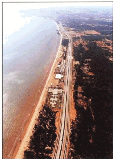
公司监理的滨海大道西延线工程
