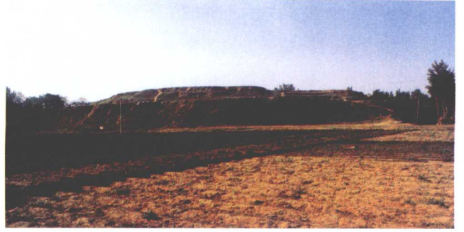
图13 河北易县燕下都武阳台主体宫殿建筑夯土台现场照片
