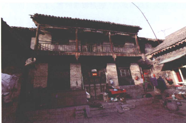
图4 山西泽州大阳镇民居普通台基
