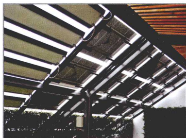
屋架平板集热太阳能热水系统 Solar Heat Water System
