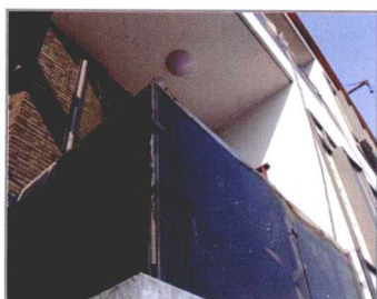
阳台上的太阳能发电系统 Solar PV Generation (Balcony)
