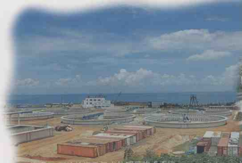
日处理30万吨的海口污水处理厂施工工地。
