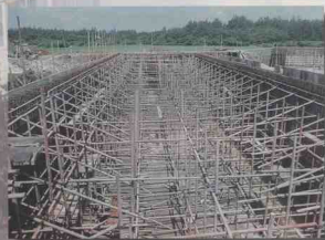
省优工程施工现场。
