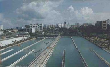
海口米铺水厂二期扩建工程。
