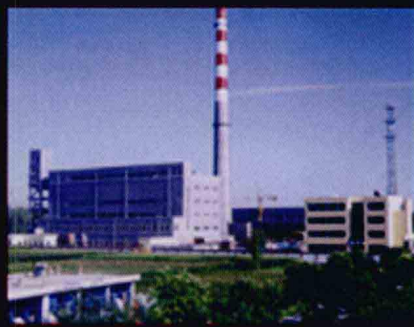
新建成的热力公司厂区
