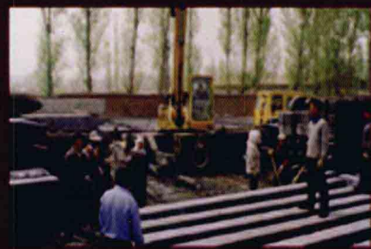
建材制品厂生产现场
