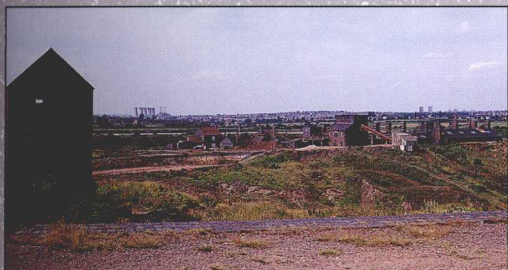
废弃煤矿的地表可能随时坍塌。
