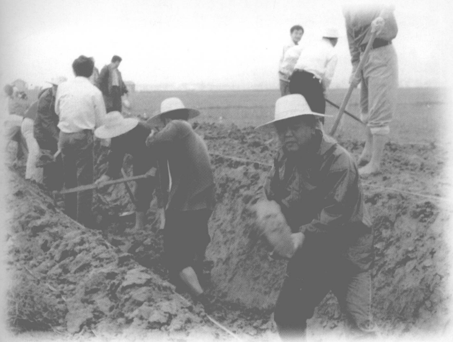
杨树岷同志在水利工地上
