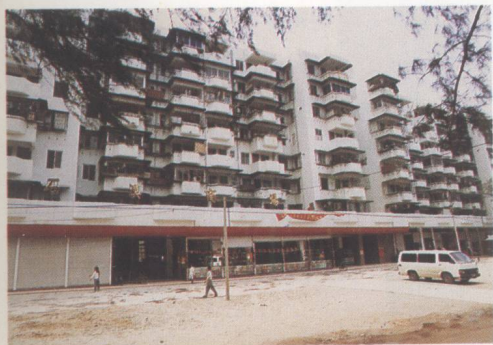
图二 城市化的石溪村农民住宅楼
