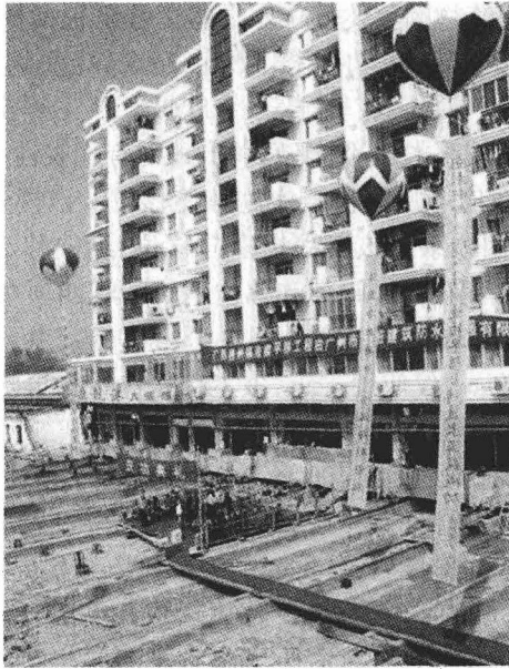
图 1-2 平移到位后的福港楼
