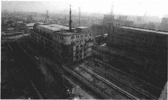
图1-5 移位中的西安市某船形建筑
