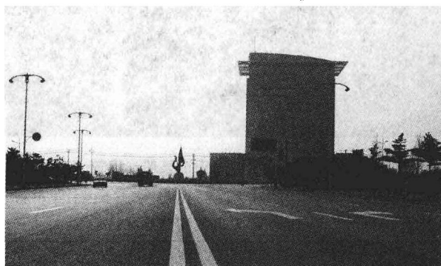
图 1-4 移位后的山东莱芜市高新开发区办公楼
