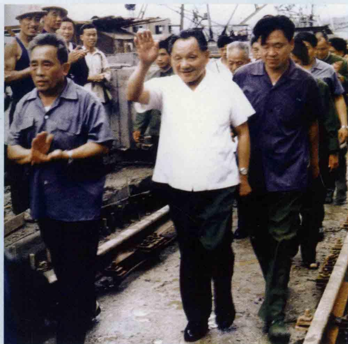
1980年7月，邓小平副主席视察葛洲坝工地
