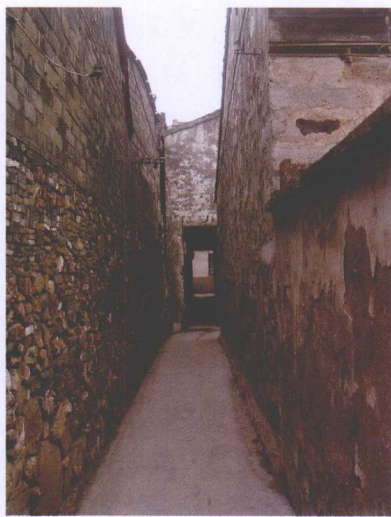
图 1-17 黄石筑成的墙基
