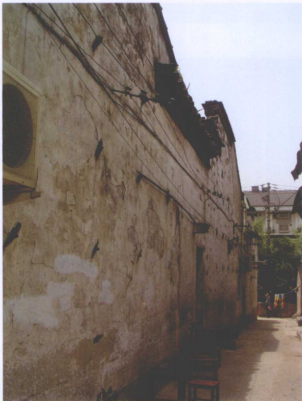
图 1-1 铁搭钉固定墙面
