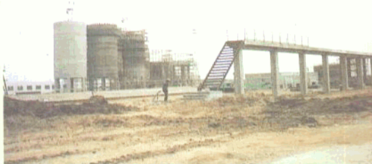
正在施工中的鴨河口發電廠——儲灰罐
