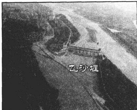
图注:飞沙堰的自动排沙
