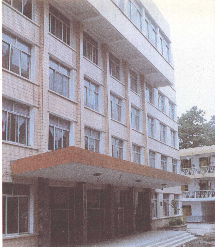
中国人民政治协商会议盐亭县委员会办公大楼
