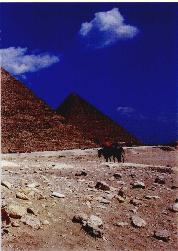
塔、孟卡拉金字塔。
