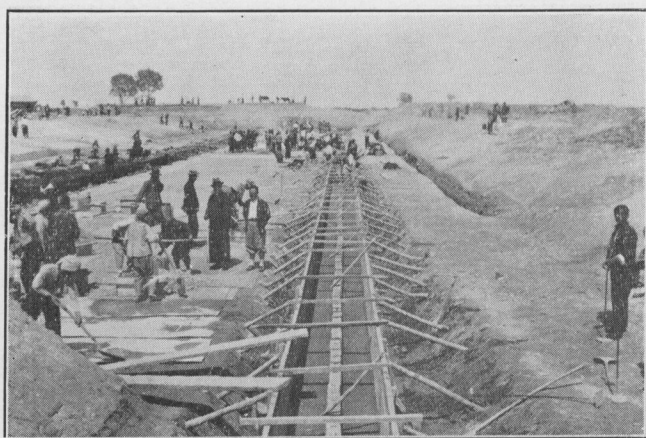
(10) 打築滾水壩板樁頂混凝土(一)
