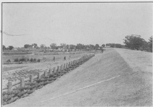
(6) 中泓南堤及木樁護岸完工情形(二)
