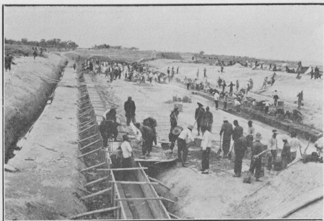
(11) 打築滾水壩板樁樁頂混凝土 (二)
