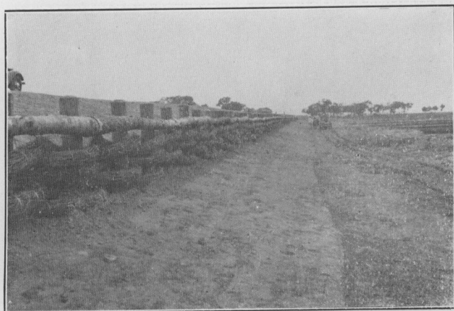
(8) 中泓南堤木樁護岸近景
