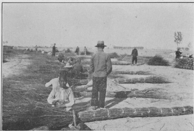
(21) 編捆中泓南堤木樁護岸柳捆
