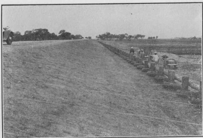
(7) 中泓南堤及木樁護岸完工情形(三)
