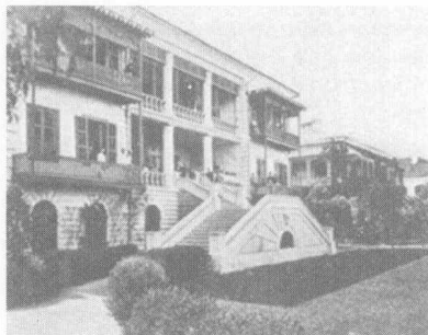
图1-5 旗昌洋行南楼、北楼历史照片
