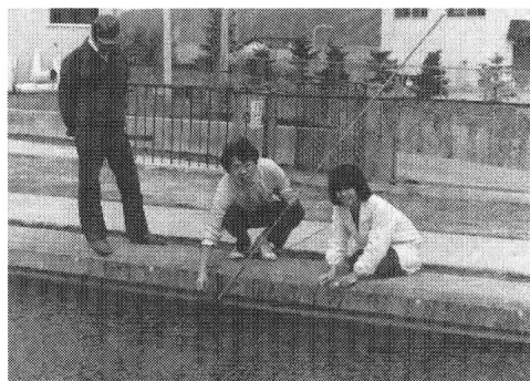
图 2 上田市染屋自来水厂过滤池水面出现看似肮脏的藻类。自从藻类浮现，过滤效果更好了。
