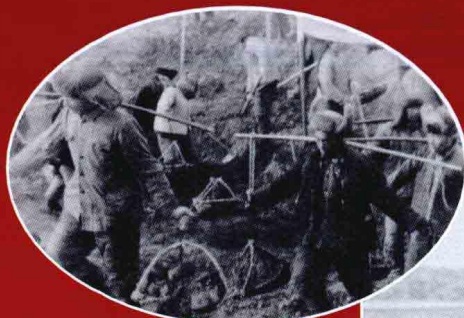
修筑额敏水库
