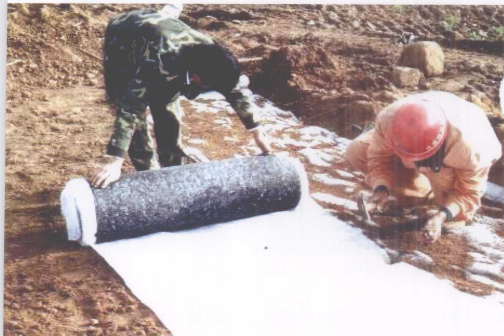
北京长河水系河岸段生态植生带护坡施工(2000年5月)
