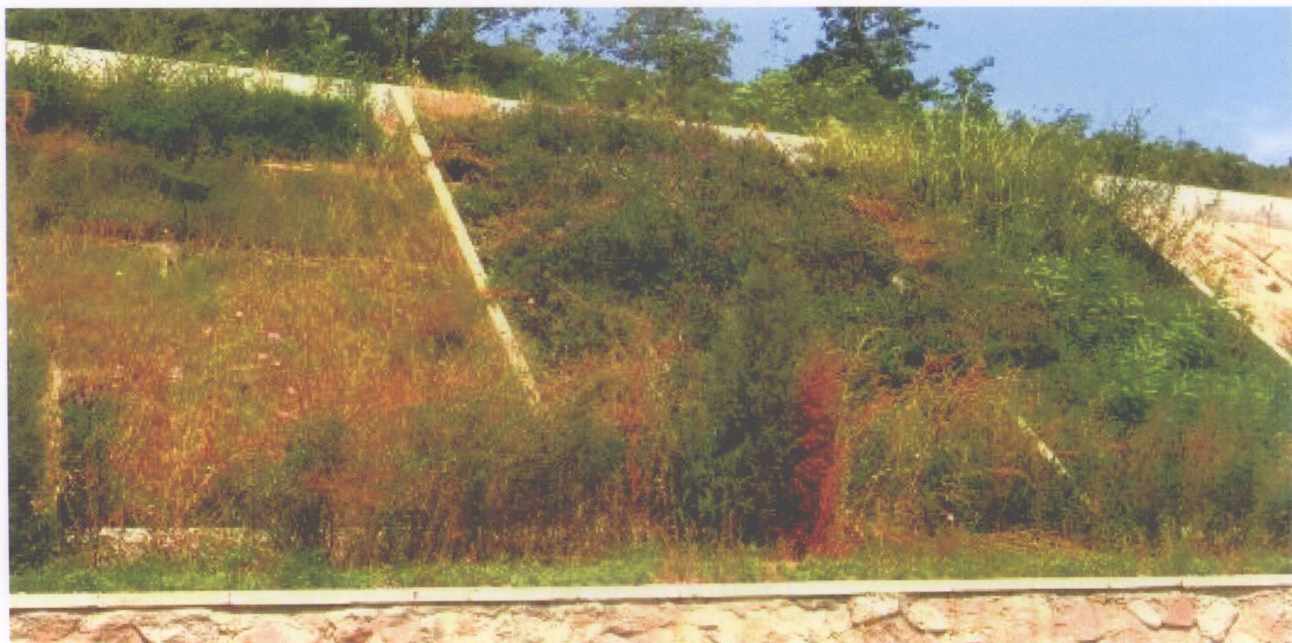
生态植生带护坡完工后 (北京市开发建设项目水土保持试验示范基地, 2008年9月)
