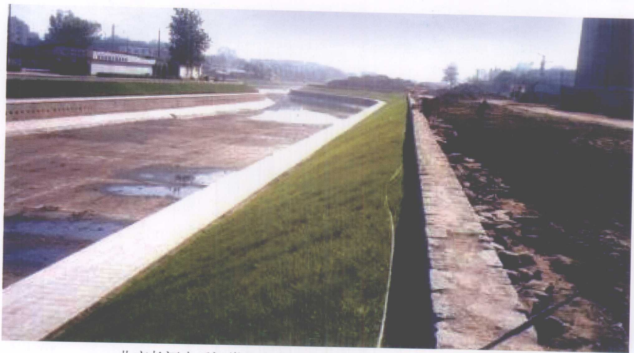
北京长河水系河岸段生态植生带护坡完工后 (2000年10月)
