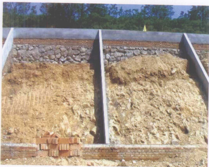
生态植生带护坡施工 (北京市开发建设项目 水土保持试验示范基地, 2007年8月)
