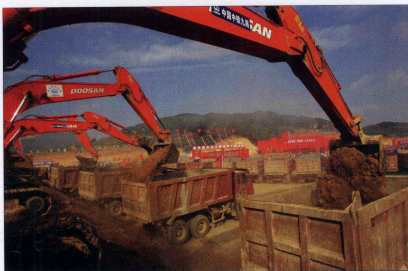
11月23日，厦深铁路厦门段正式开工。图为施工现场。（梁伟 摄）
