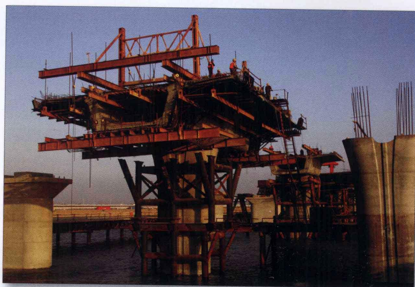
建设中的杏林公铁大桥
