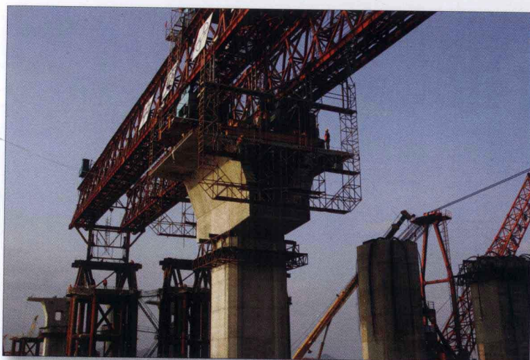
集美大桥进行主跨箱梁拼接作业
