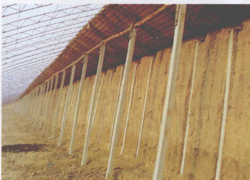
图1-10 土墙钢筋骨架温室
