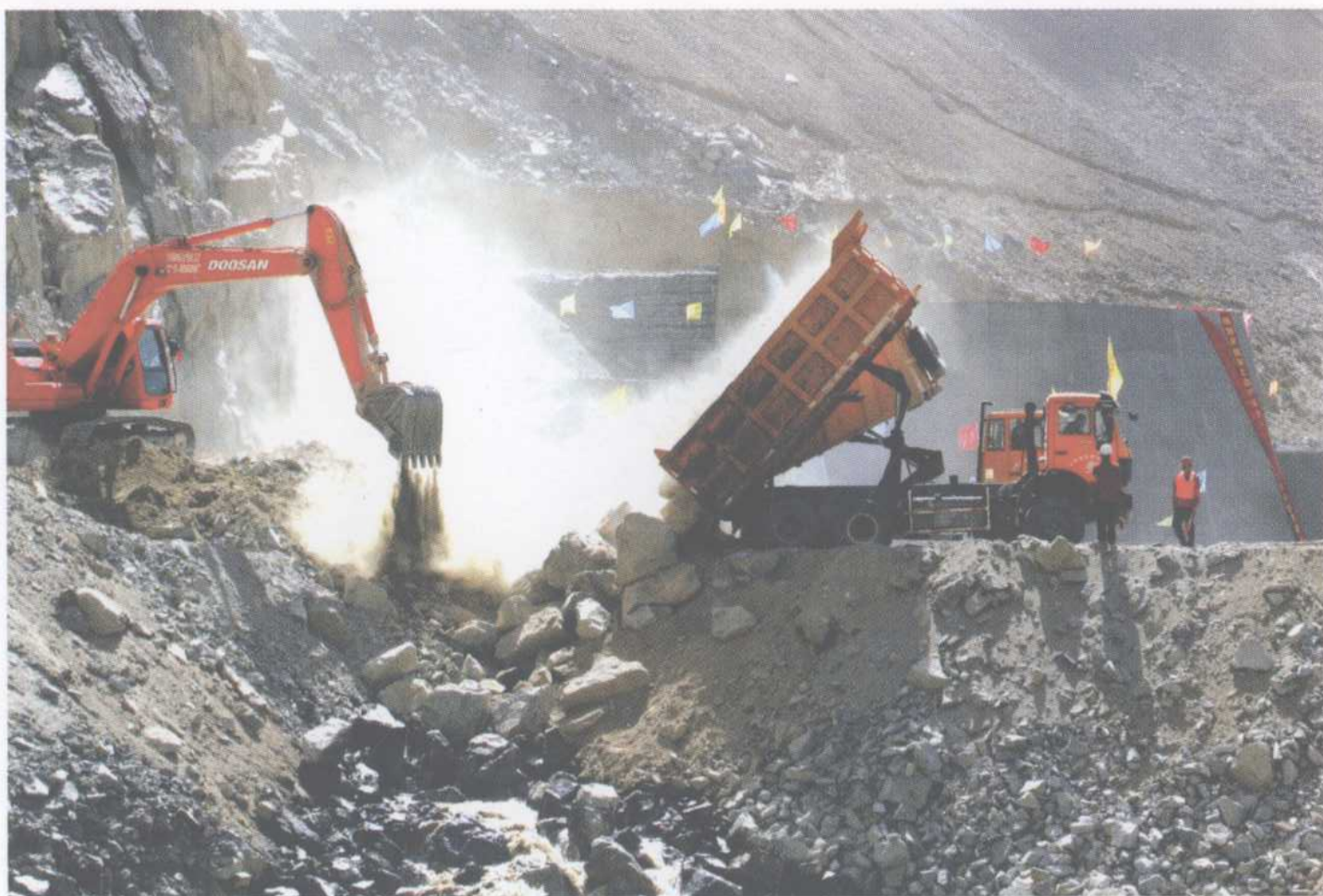
建设中的下坂地水利 枢纽工程 (张开瑚 摄影)
