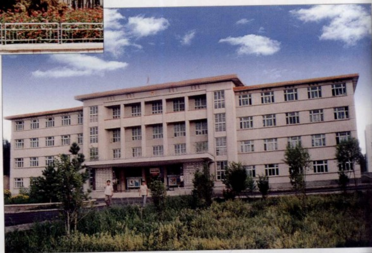
▼ 额敏县人民政府机关办公大楼(1990年)
