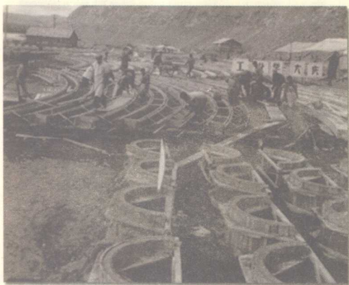
知青们在建筑工地施工
