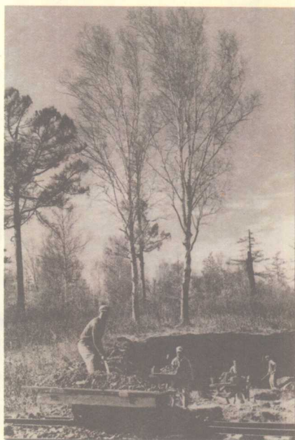
知青们在修筑铁路
