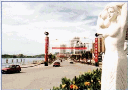
三亚市西河西路, 长 2200m, 宽 36m, 砼路面, 投资 5200 万元。
