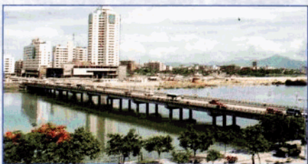
三亚市新凤桥, 长 220m, 宽 15.5m, 预制砼 T 梁结构, 总投资 1200 万元。
