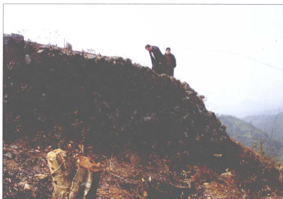
关隘墙体外侧
