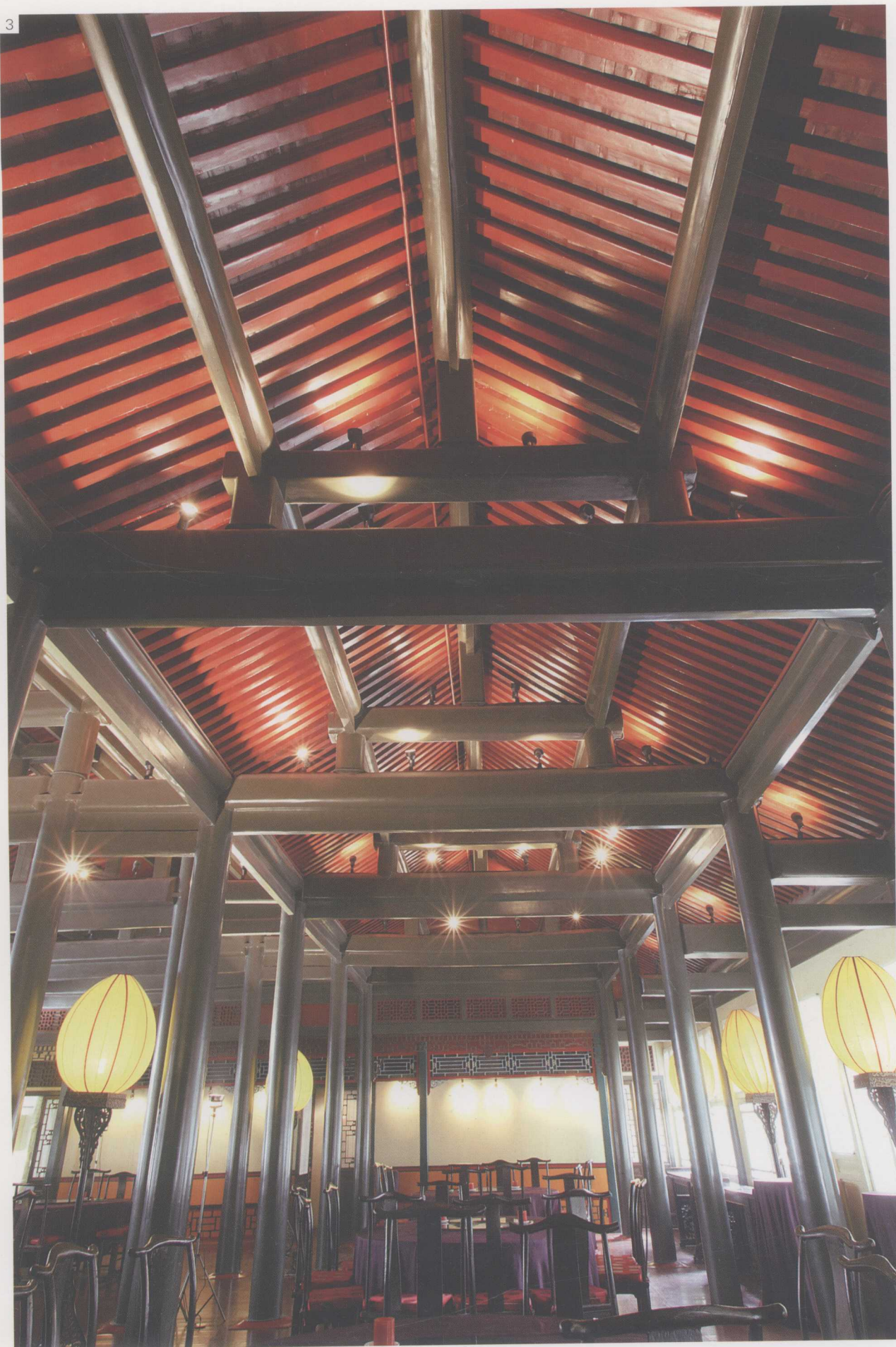
3. 传统屋顶的梁柱结构成了这里的特色。
