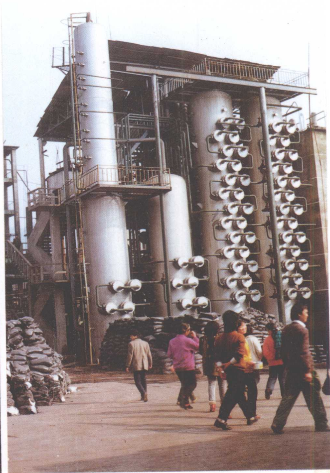
△ 邻水氮肥厂合成塔
