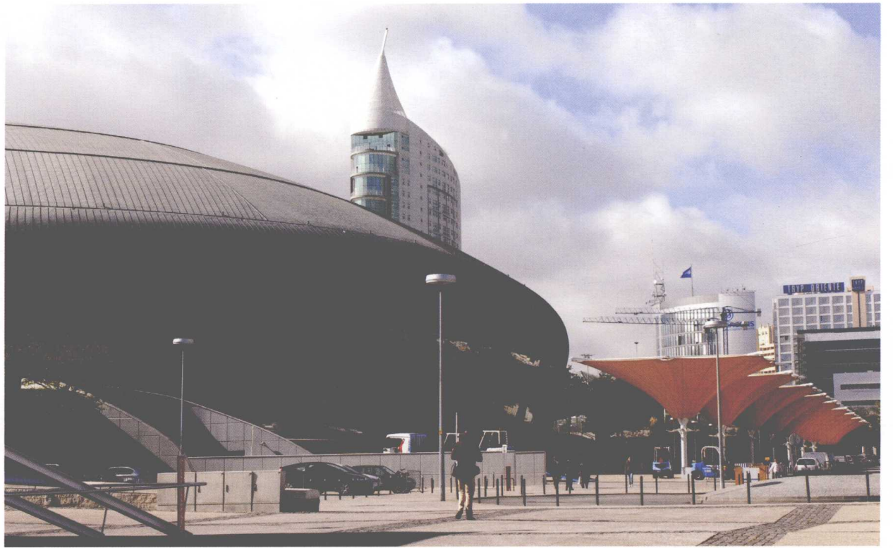
从技术角度来看，该馆具有节能特点。外部涂料用锌—石英。该馆是七个“欧洲2000年节能”项目之一，节能比率最高可比同规模建筑物节约50%，同时可减少二氧化碳的散发，并可减低空调系统带来的环境影响
