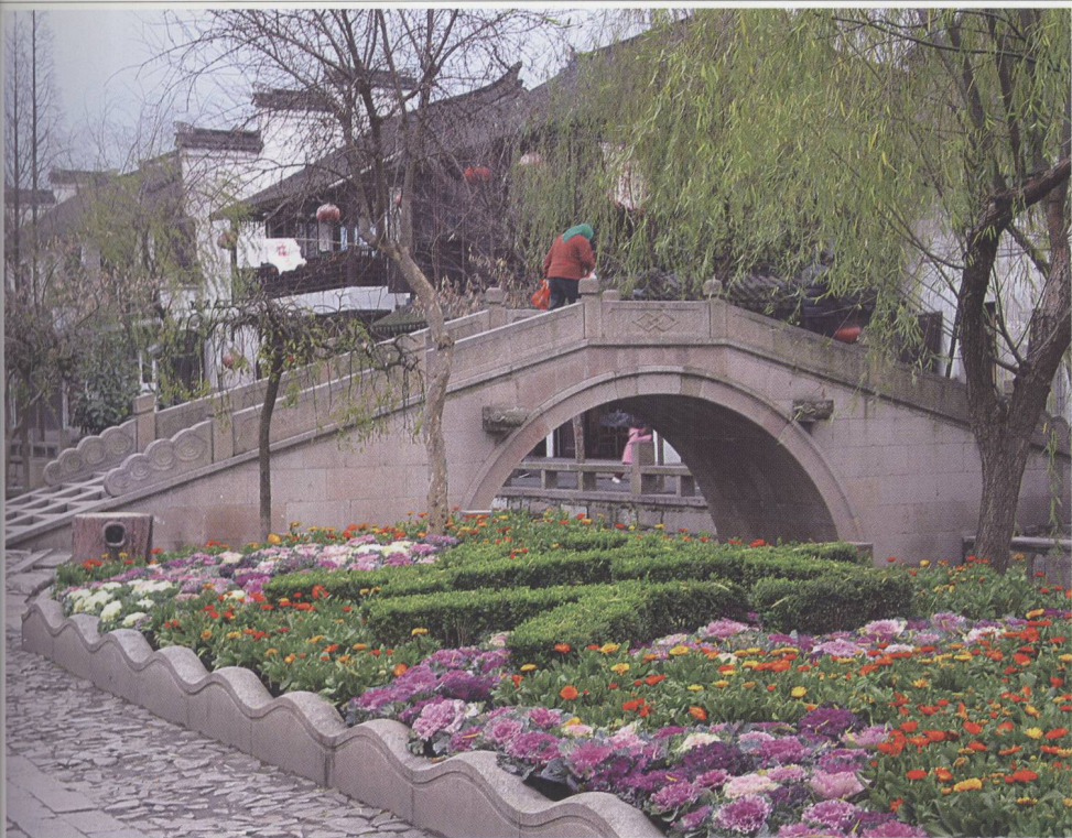
青龙桥 Qing Long Bridge 青龍橋 청용교(靑龍橋)
