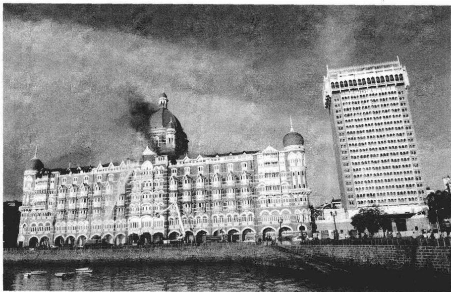
泰姬玛哈酒店连续发生了6起爆炸，顶部被炸开，浓烟滚滚
