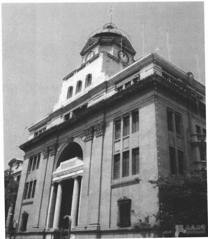
中国农业银行旧址（原大陆银行大楼），位于北京西交民巷东口
