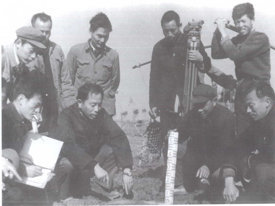
1979 年在安乡冬修水利工地上,钦时中与技术人员研究施工方案。
