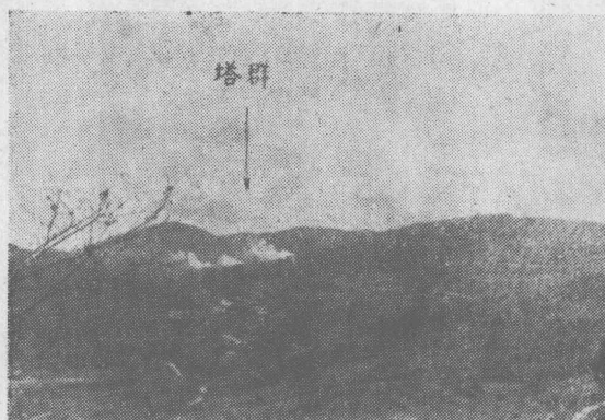
图4 拉德瑞罗——地热电站蒸汽塔群
