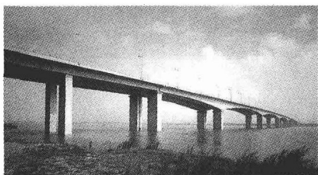
图 1.6 南京长江第二大桥北汊桥
