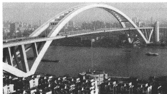
图 1.9 上海卢浦大桥
