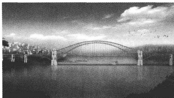
图 1.8 重庆朝天门大桥
