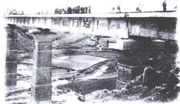
彭水民兵团修建襄渝铁路大桥
