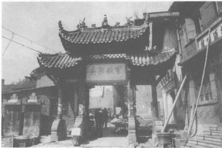
屈原故里牌坊
