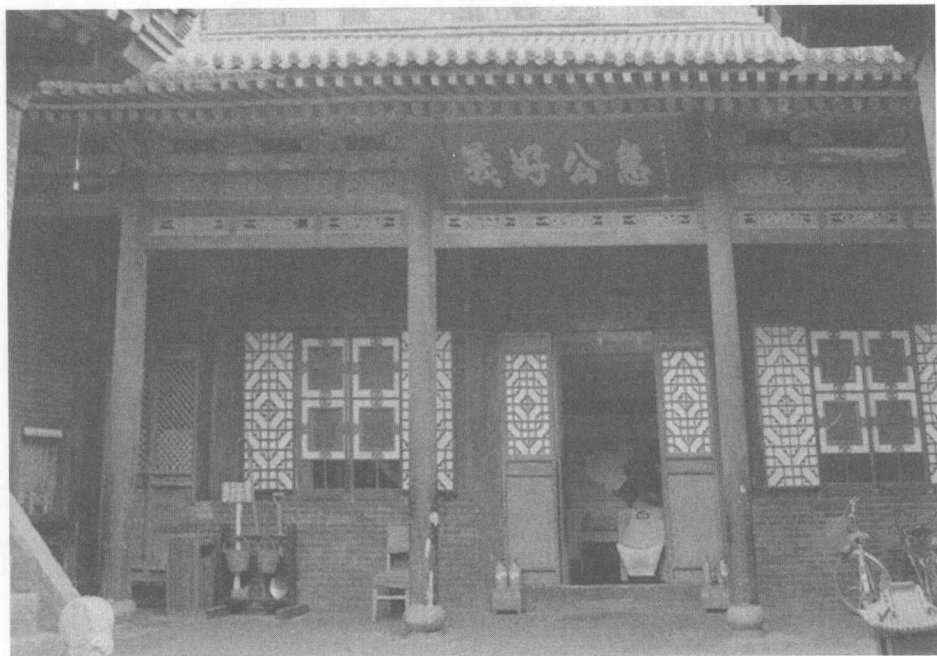
山西巡抚岑春煊给“日升昌”送的“急公好义”的牌匾
