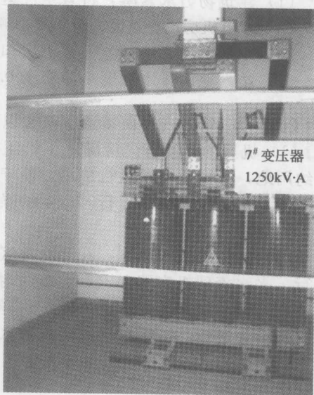
图 1-1 干式变压器
