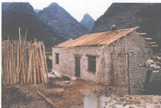
布依族正在修建中的新房
