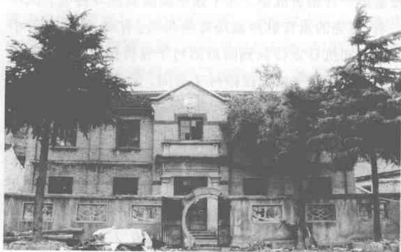
章水镇崔岙村启明小学的教学楼
