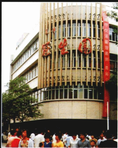
冠生园营业楼
