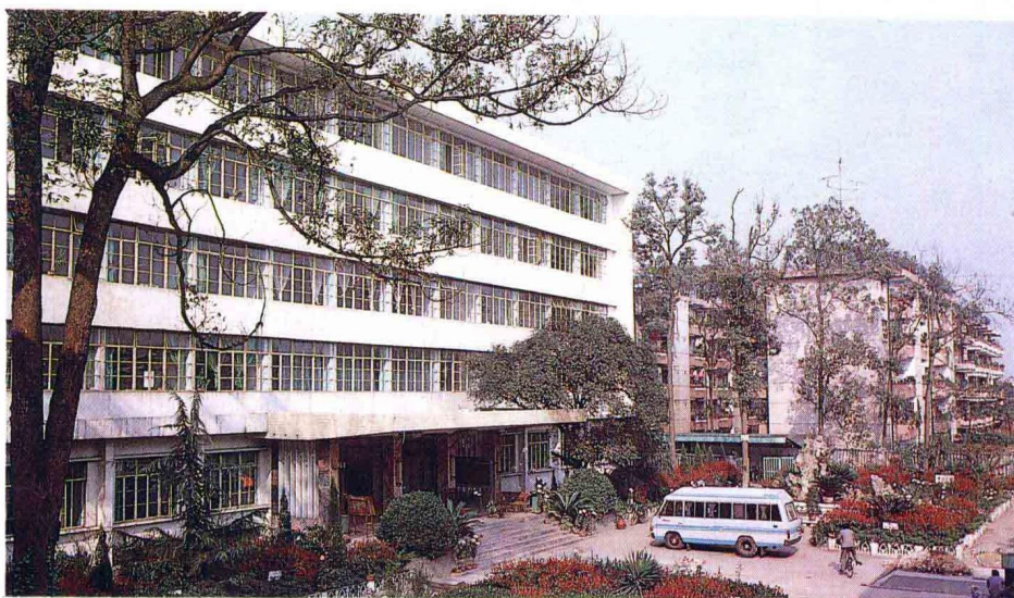
县政府办公大楼
