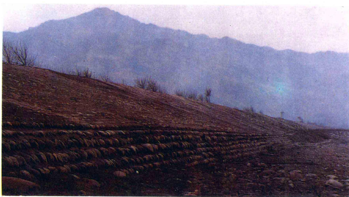
石亭江防洪大堤
